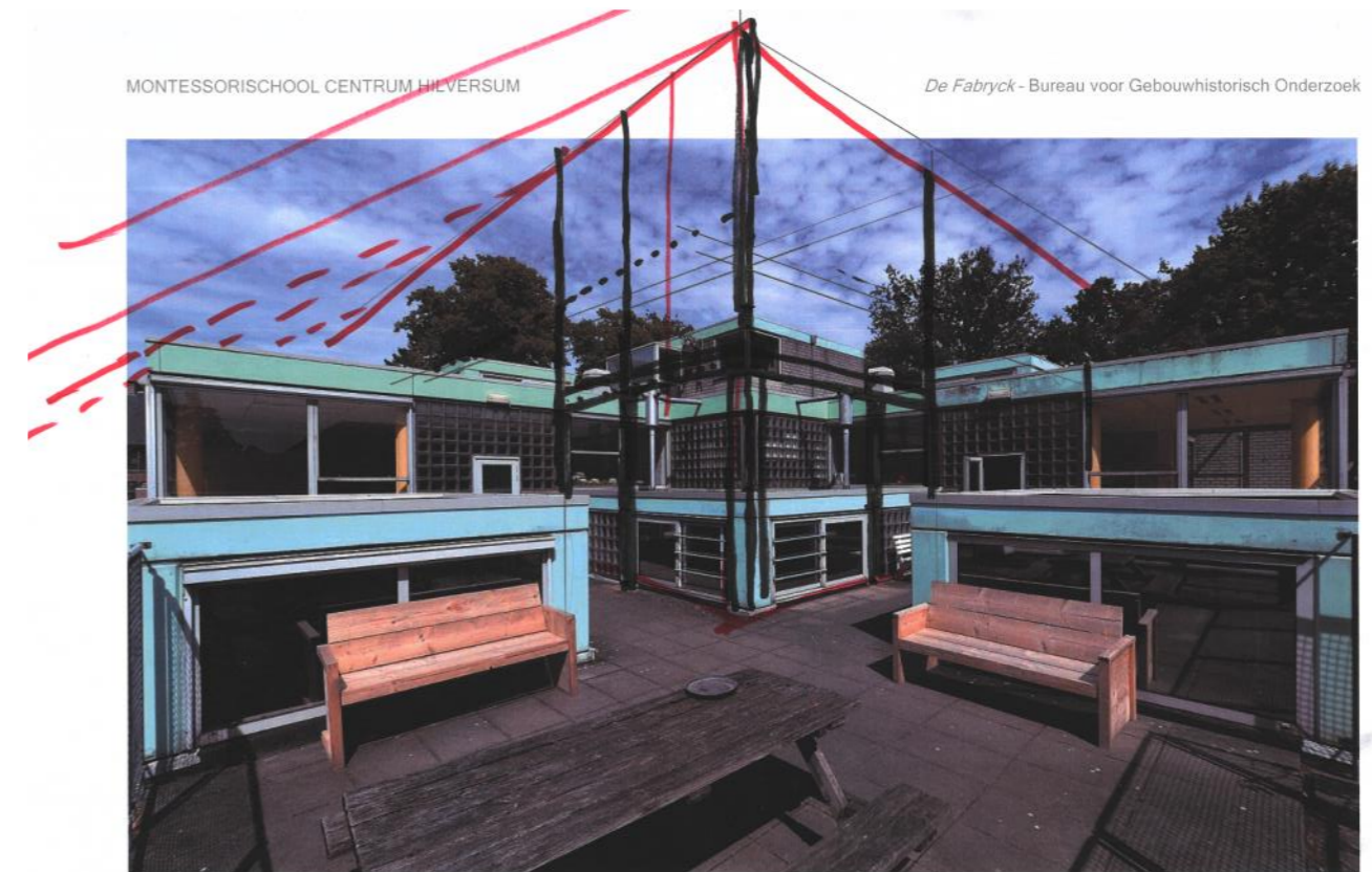
73. Dakterras aan de zuidwestzijde boven de begane grond, met links leslokaal 1.08 en rechts 1.09; in 1986-1987 was hier al een omheind terras i.v.m. de twee vluchttrappen.
